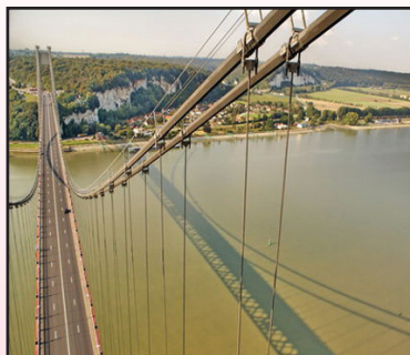
Les câbles du pont de Tancarville et leurs ombres dans l'eau. Leur forme est celle d'une parabole.
